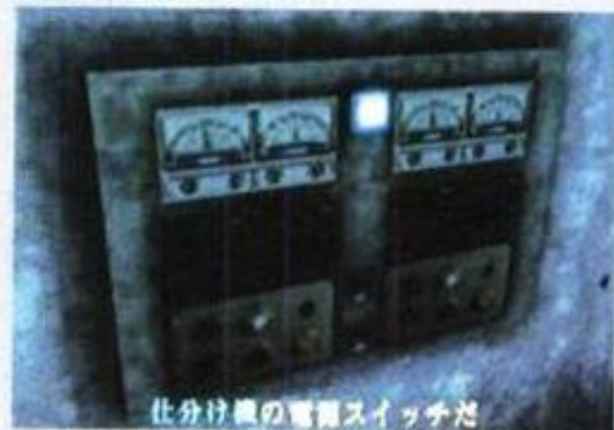
▲ 컨베이어 벨트 조작 패널. 이것 먼저 누르고
