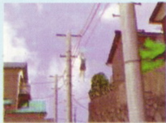
DEN SEN ELECTRIC WIRES
