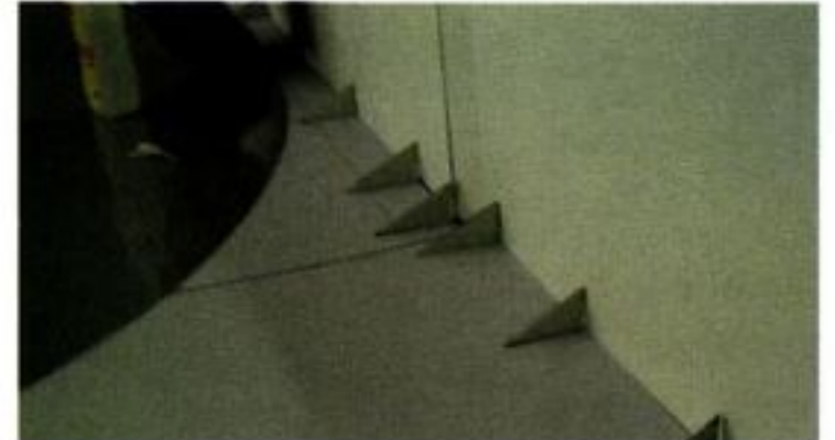
▲ 이것이 바로 우카레로 벽세우기 공법!
