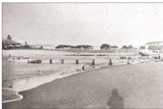
Ambrizete - Ponte construída pela Marinha.
