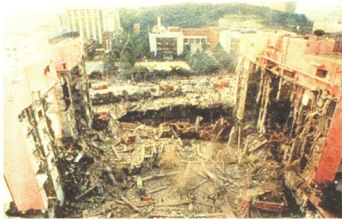
▲ 95년 6월, 아베 상자로 남아있는 S백화점 붕괴 시점. 시점 용이 3층 모이던 계층, 나뉘은 사람은 부실 공사의 책임을 지고 모든 사람에게 돈을 나눠주는 규칙, 정밀 기가 막히지 않을 수 없다
